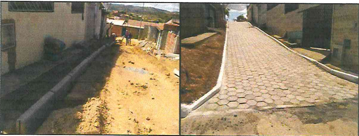
4 - MANUTENÇÃO EM REDE DE DRENAGEM PLUVIAL
