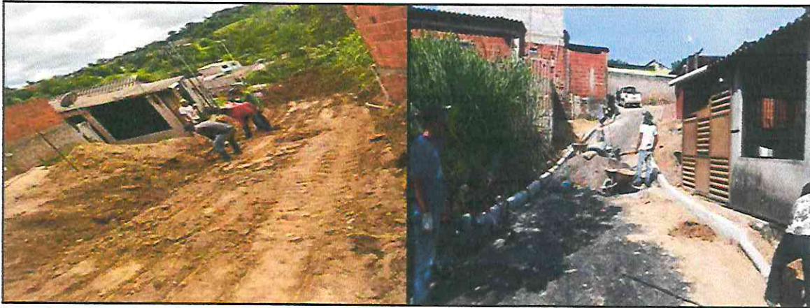
6 - CONTENÇÃO DE EROSÕES
