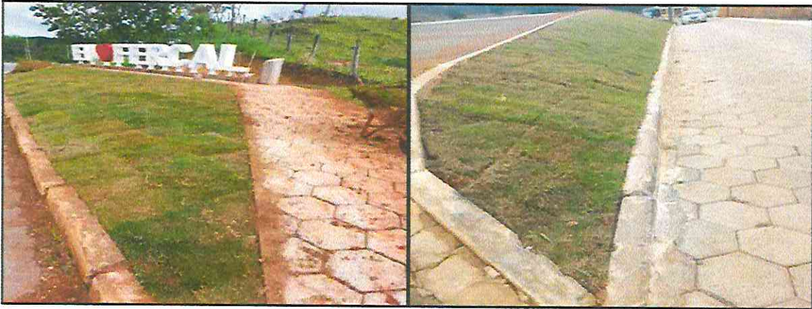
3 - PAVIMENTAÇÃO DE RUAS COM BLOCOS DE CONCRETO
